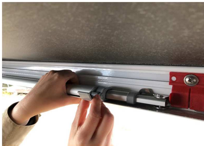
⑧固定レバーを起こしてストッパーから外します。
